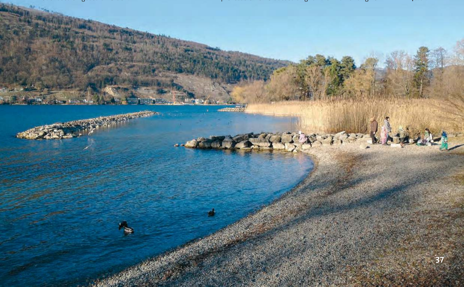
Renaturierte Flachwasserzone mit Erosionsschutz beim Erlenwäldli in Ipsach.
