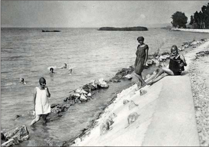
Abbildung 1: Neue, ca. 3 km lange Seeufermauer zwischen Vinelz und Lüscherz am Bielersee Ende der 1920er Jahre. Der Uferbereich wurde aufgeschüttet und anschliessend mit Ferienhäusern überbaut.
