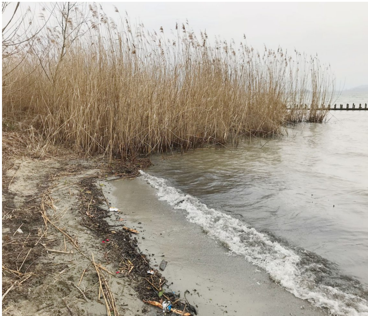
Uferschutz: Hinter den Lahnungen (im Hintergrund) am südlichen Ufer des Bielersees konnte die Erosion gestoppt werden. Auf neu entstandene kleine Sandbuchten ist Bauleiter Christoph Iseli besonders stolz. Lotti Studer
