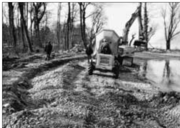
Erlenwäldli Ipsach, Flachufer im Bau (Kiesschüttung).
