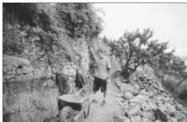
Rénovation d'un mur de pierres sèches à Tüscherz (Objet Tü 15).
