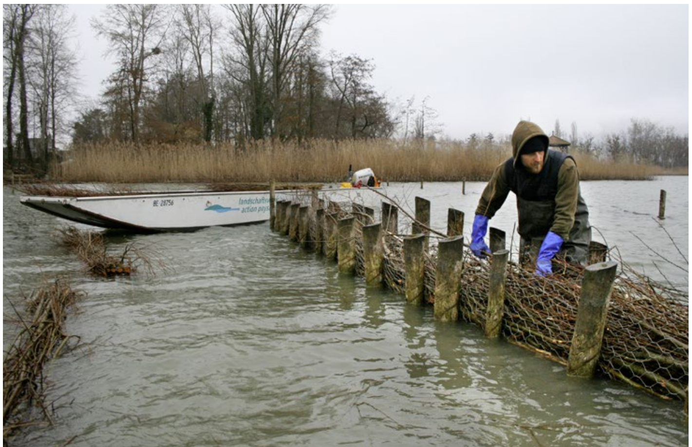
Das Landschaftswerk hat in zahlreichen Versuchen über Jahre verschiedene Methoden für die Uferbefestigung getestet, wobei sich Probleme mit der Erosion am besten mittels Lahnungen eindämmen lassen. Alle drei Jahre muss Material nachgefüllt werden, sonst verliert die Uferbefestigung rasch ihre Funktion.
