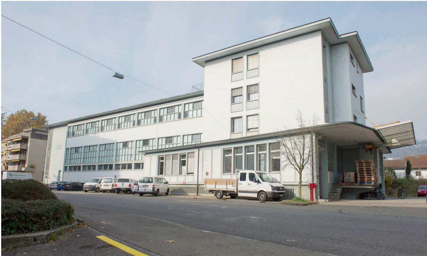
In der ehemaligen Fabrik an der Mattenstrasse kann das Landschaftswerk Werkstätten und Büros an einem Ort zentrieren. Bilder: Peter Samuel Jaggi
