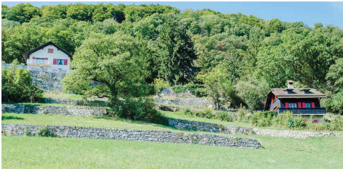
Terrassen im Hang: Diese Trockenmauern in Schernelz wurden früher für den Rebbaubau genutzt. Bilder: Matthias Käser
