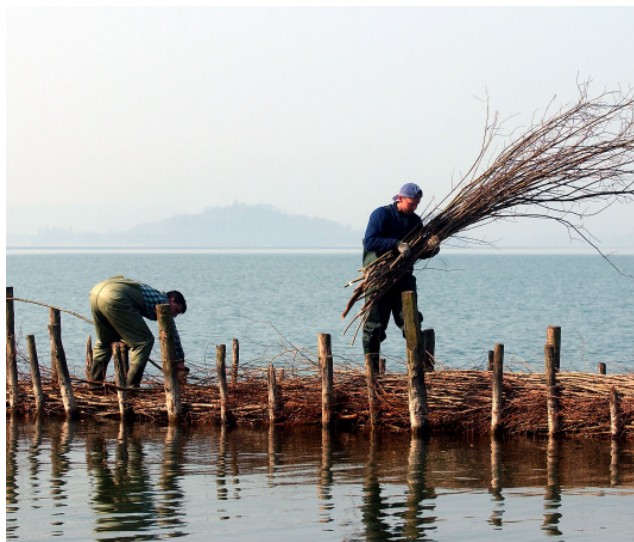
Abb. 2: Bau einer Lahnung zum Schutz von Schilfbeständen (Mörigen)
