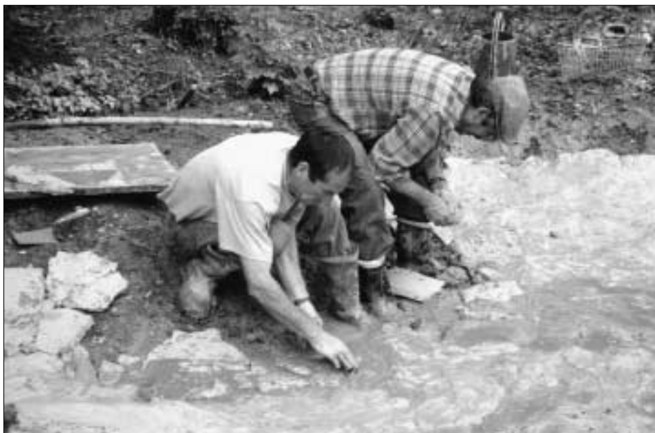
Zur Schaffung eines Tümpels wird der Boden mit Lehmziegeln abgedichtet (Täuffeln).
