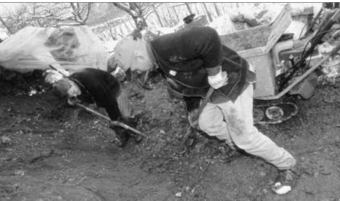
Préparation du sol lors de la rénovation d'un mur de pierres sèches par le Programme de travail SPR, lisière de forêt à Daucher.
