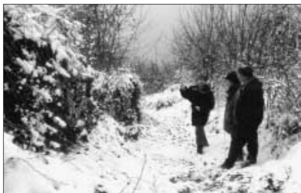
Même en hiver les travaux continuent...
