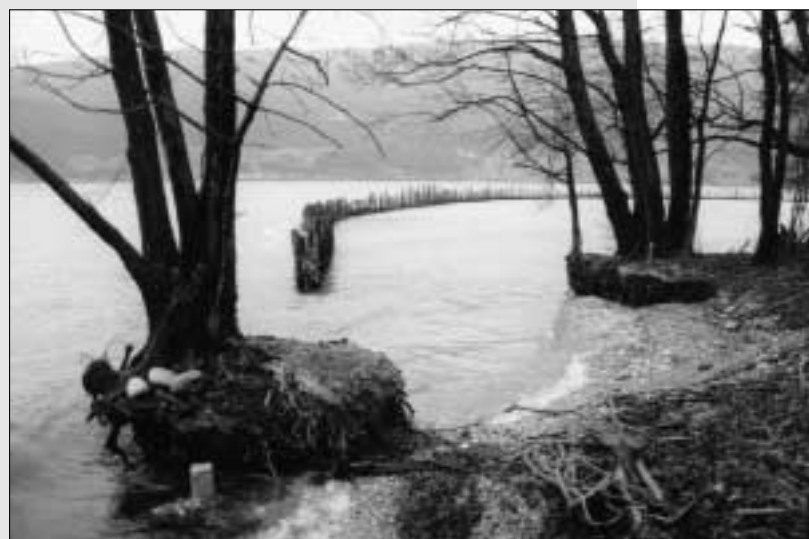
Lahnung (Wellenbrecher aus Weidenfaschinen) und Kiesschüttung im Vordergrund.
