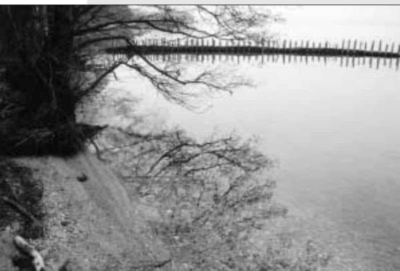
Barrage à claire-voie (composé de fascines de saule) et remblai en gravier.
