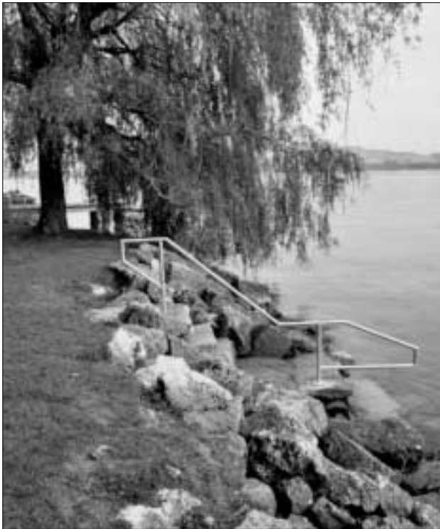
Daucher (objet 19): Balustrade des escaliers du bord du lac. Planification, design et montage par le programme de travail SPR. Les travaux de serrurerie ont été exécutés par H. Kopp-Gyger, Sutz-Lattrigen.
