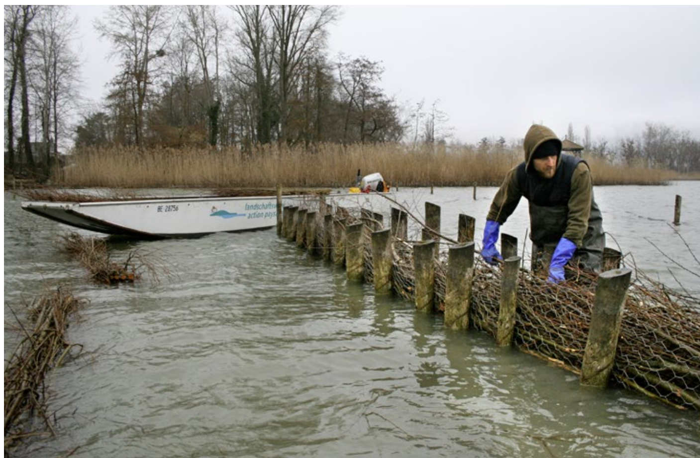
Das Landschaftswerk hat in zahlreichen Versuchen über Jahre verschiedene Methoden für die Uferbefestigung getestet, wobei sich Probleme mit der Erosion am besten mittels Lahnungen eindämmen lassen. Alle drei Jahre muss Material nachgefüllt werden, sonst verliert die Uferbefestigung rasch ihre Funktion.
