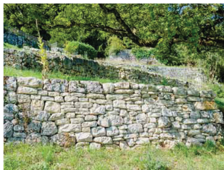
Neuer Glanz: Für die Restaurierung wurde heller Jurakalkstein aus der Region verwendet.
