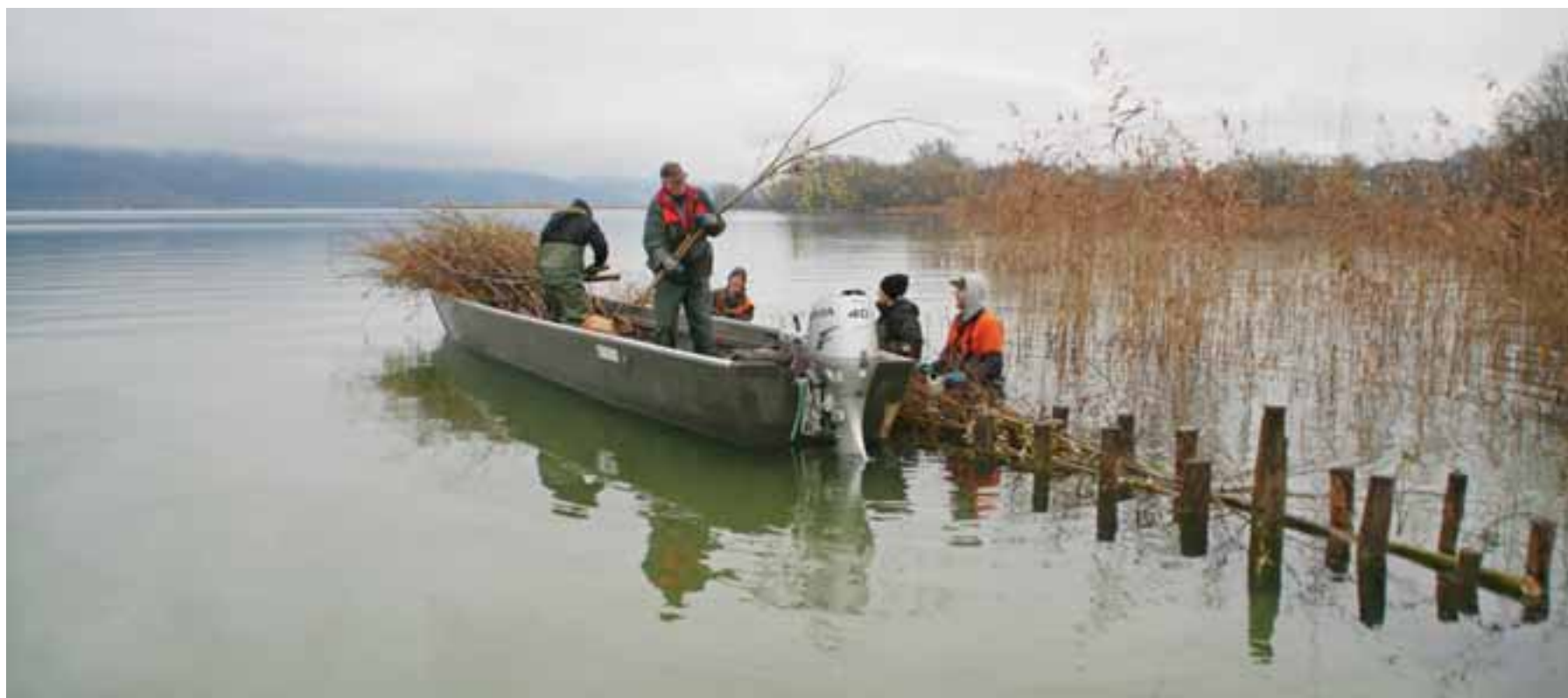
Lange Ruten: Eine Gruppe vom Landschaftswerk Biel-Seeland füllt vor Lüscherz eine Lahnung mit neuen Weidenzweigen. Eine typische Winterarbeit.
